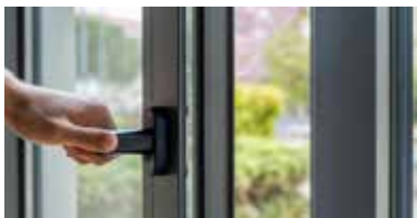
Door & Window framing
